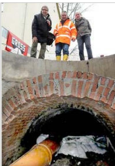
Die Betonsohle in dem Gewölbe haben die Bauarbeiter bereits mit dem Presslufthammer für den Abtransport zerkleinert. Durch das Kunststoffrohr fließt derzeit der Krähenberger Bach. Fotos (2): Ralf Sichelschmidt (v.l.) Hans-Christian Schäfer, Dipl.-Ing. Andreas Gohl und Ludwig Vennhoff (Technische Betriebe) an einem der Bauschächte.
